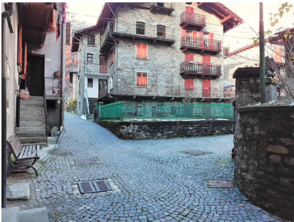
INTERVENTO A NORD DELLA CHIESA PARROCCHIALE
